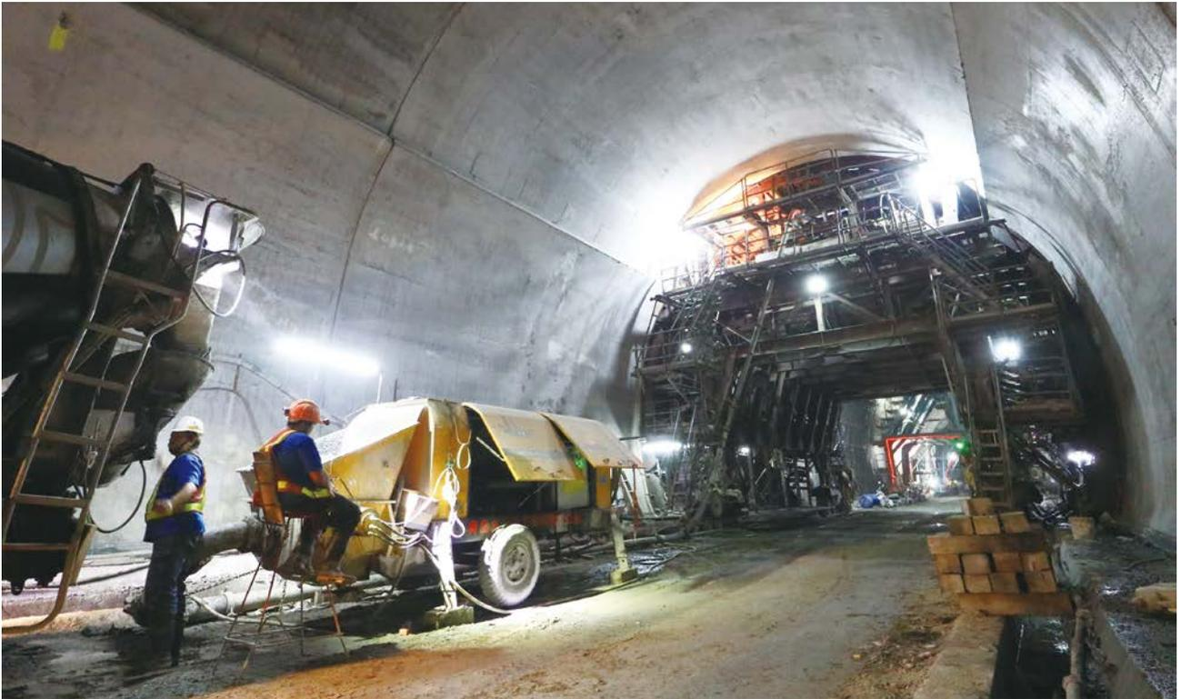
北口北上線往南 (NS3)-襯砌 (NO.81) 混凝土澆置。
