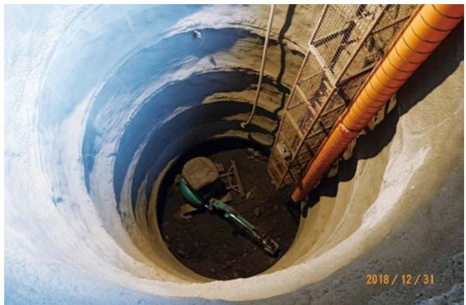
南洞口清水溪橋A1橋臺井式基礎開挖。
