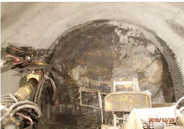
排氣排煙隧道先撐鋼管鑽設。
