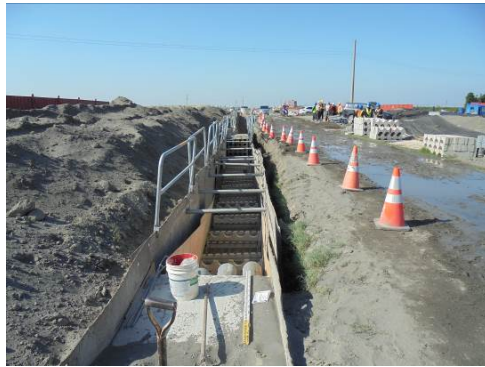
執行施工中監看作業並記錄現場施工情形
