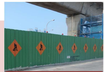
工區周界圍籬
