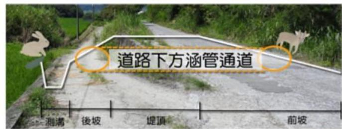
側溝版橋、順水流向的道路下方通道
