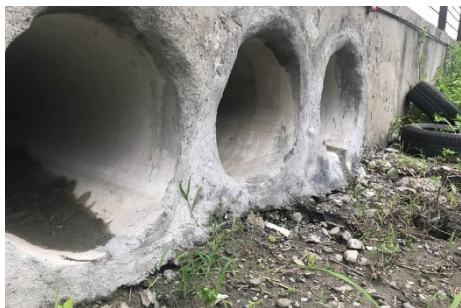
涵管削平、高差填補
