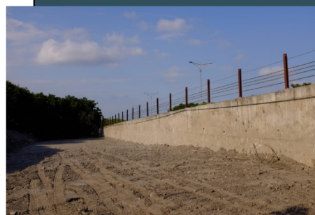
移除北引道土坡
