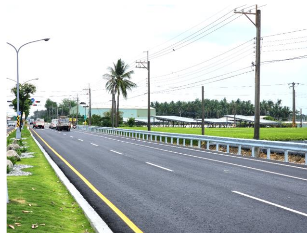
3 周邊護欄改善
