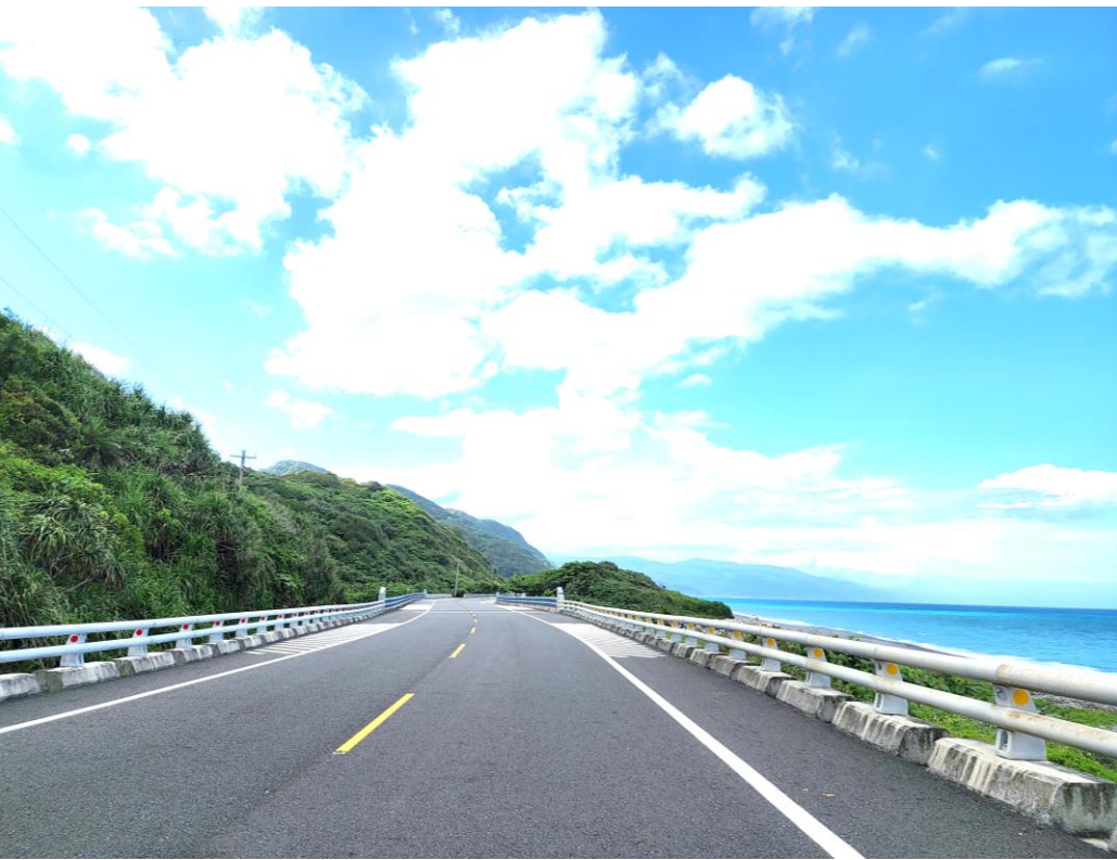
安全通透的鋼管護欄
