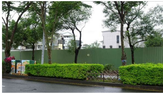
架設施工圍籬
