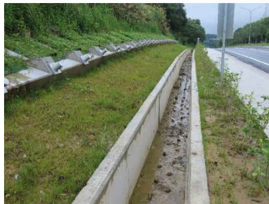
新設U型明溝
