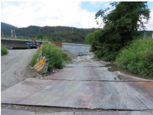
施工便道-使用防汛道路
