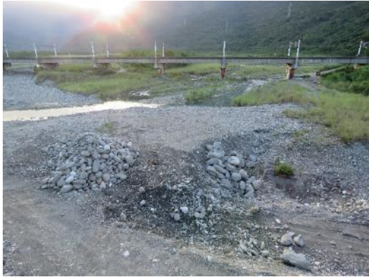
上游灘地及施工便道
