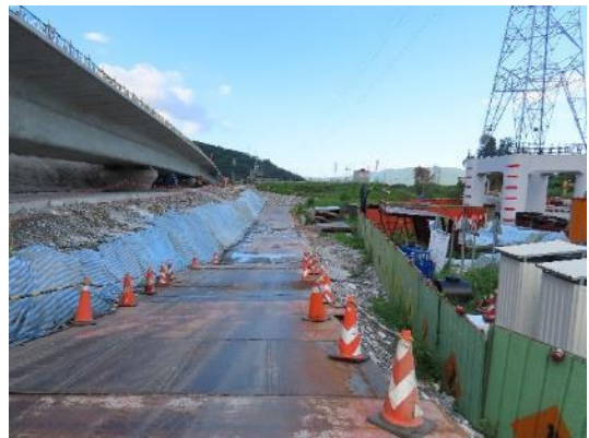
施工便道-使用灘地
