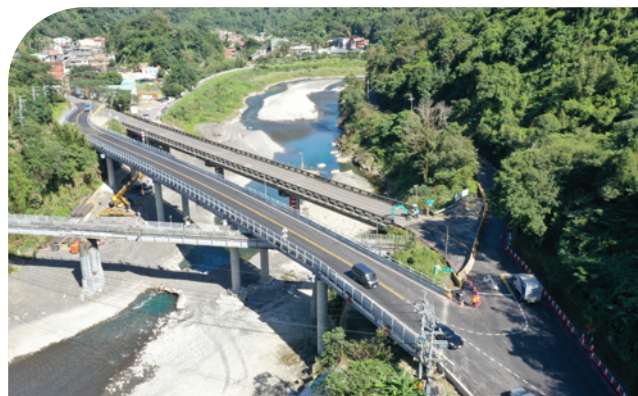
原上龜山橋未拆除前先行興建臨時鋼便橋供通行
