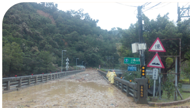
104 年蘇迪勒風災上龜山橋大水淹過橋面
