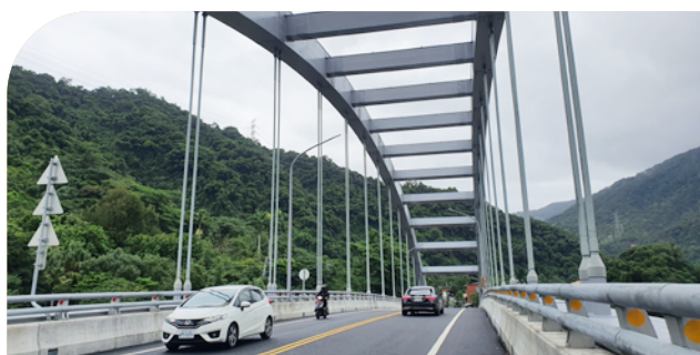
新上龜山橋 111 年 8 月 29 日已全面通車
