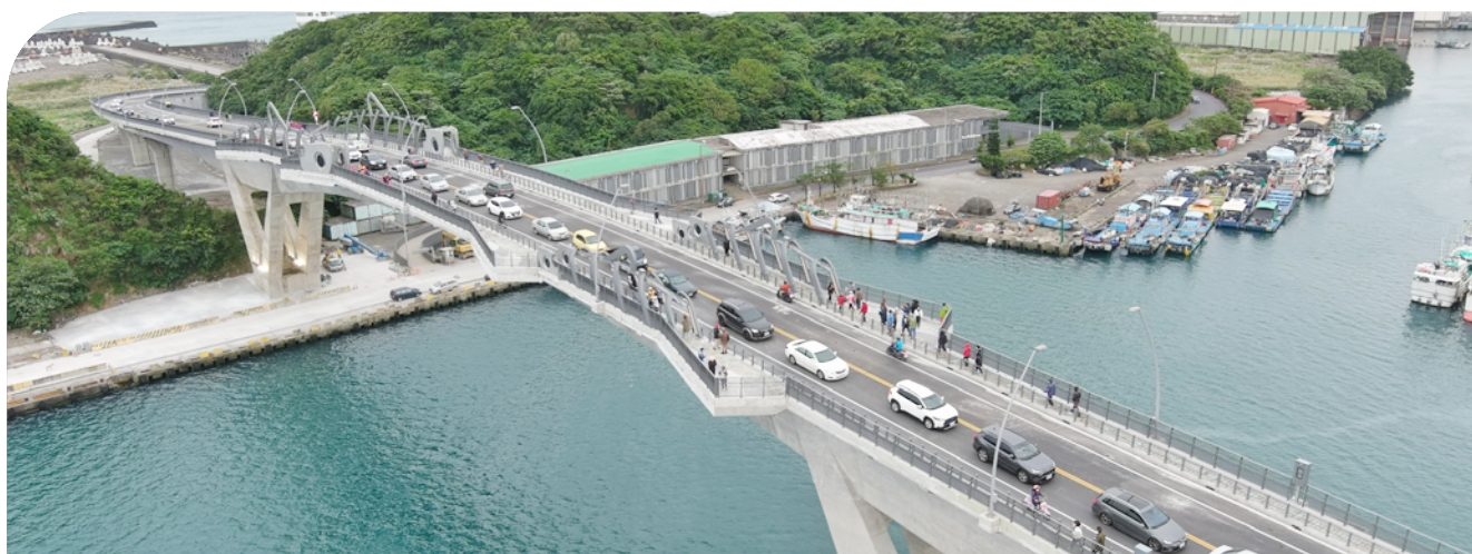
南方澳大橋重建工程完工，通車當日橋上人潮及車流
