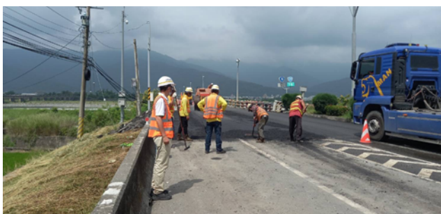
台9線玉里大橋(南下)A2伸縮縫處路面緊急搶修
