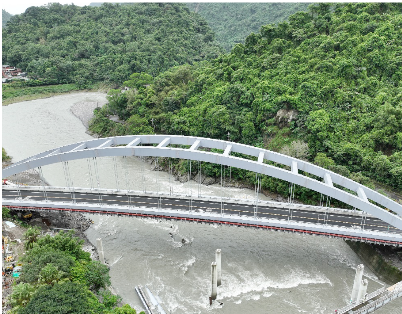
新上龜山橋通車後空拍
