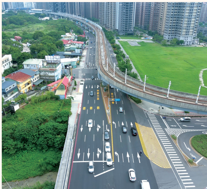
台 2 線 7.8K 濱海路口改善完成
