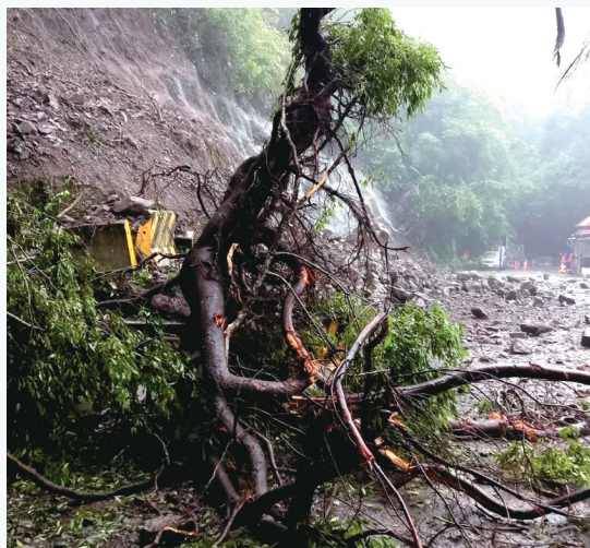
隧道洞口落石及枯樹掉落情形
