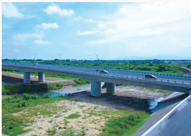
急水溪橋下游側橋梁全景
