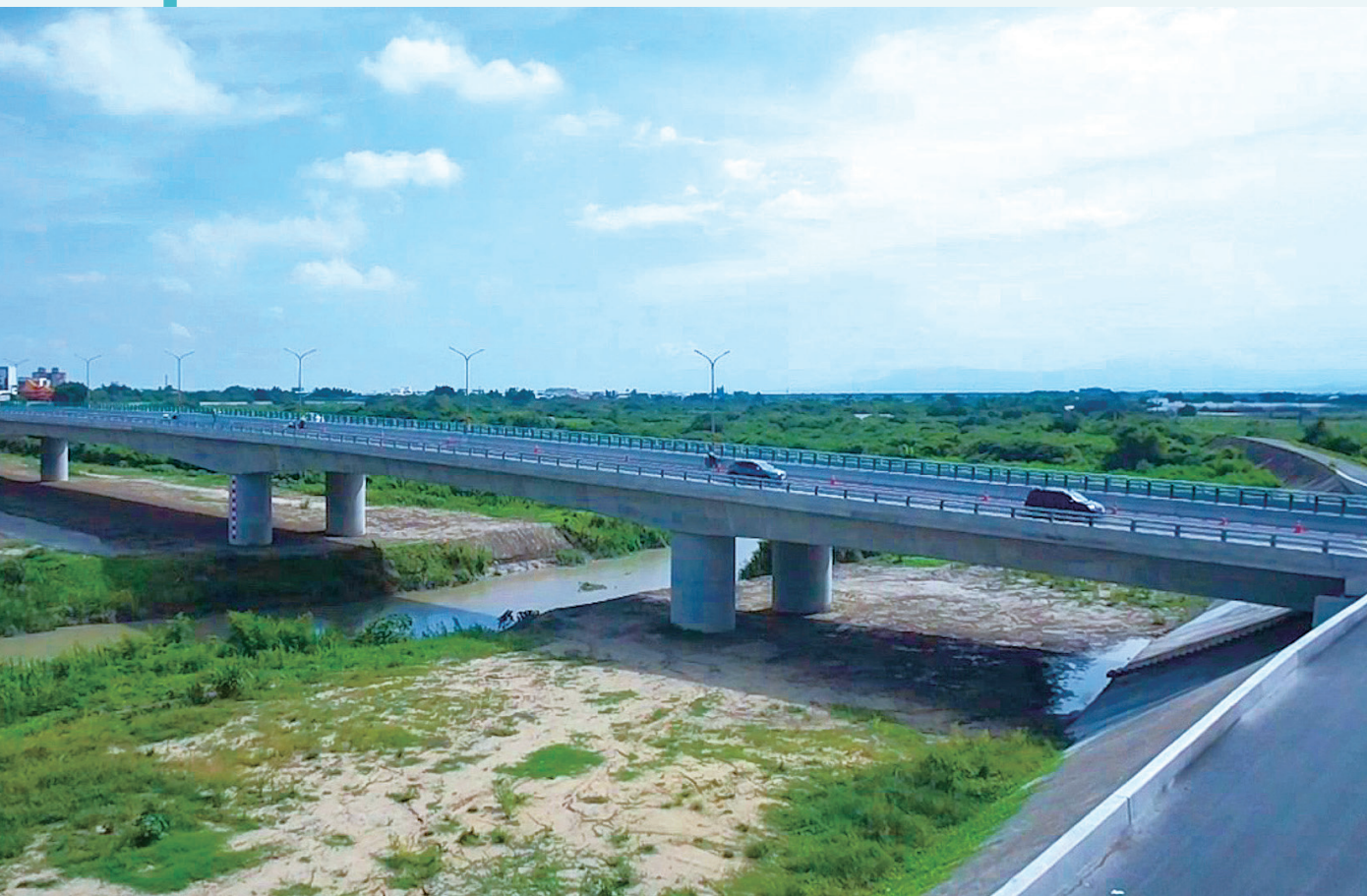
台 1 線急水溪橋改建工程下游側橋梁全景
