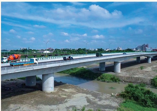
急水溪橋上游側橋梁全景
