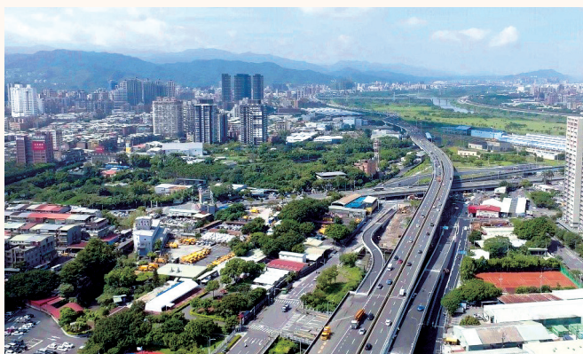
浮洲匝道空拍圖（北上匝道）
