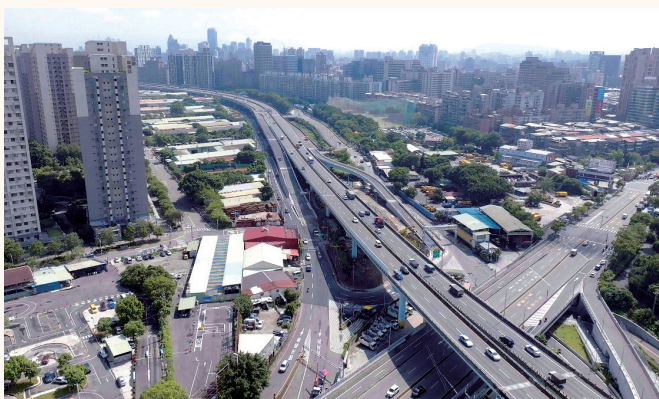
浮洲匝道空拍圖（通車前施工照）
