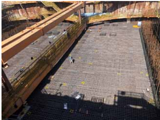
圖 2-13 樁帽澆置孔及場撐基座鋼筋
