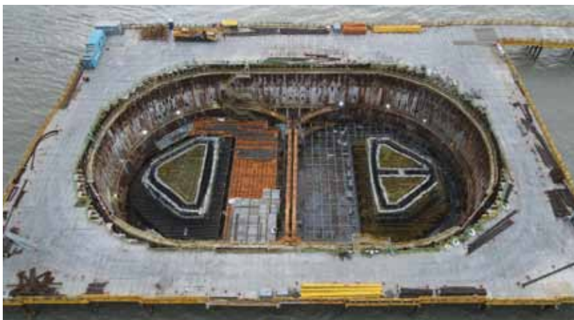
圖 4-5 橋塔外型 (主筋預留)
