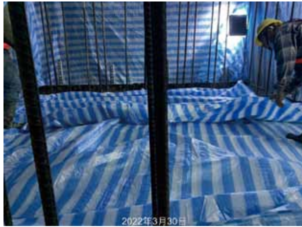
圖 3-5 上側保溫材 - 帆布鋪設情形
