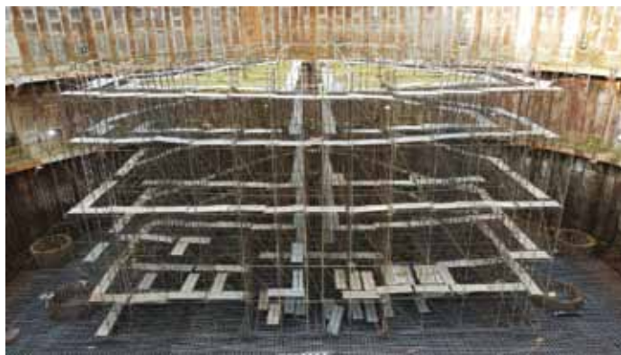
圖 2-5 主橋塔塔柱鋼筋樣架組立完成 -1
