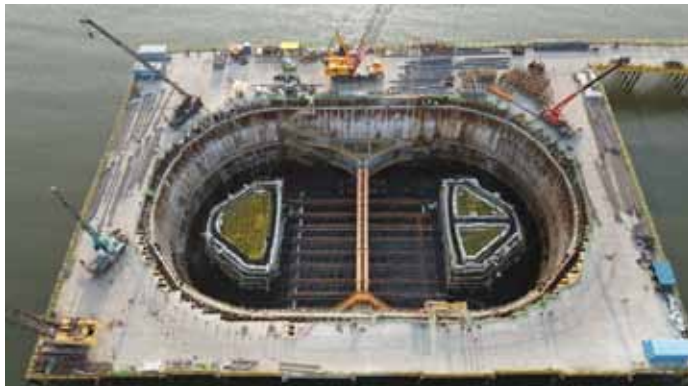
圖 2-11 樁帽上層鋼筋綁紮作業
