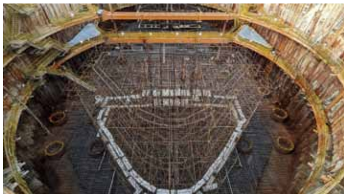
圖 2-6 主橋塔塔柱鋼筋樣架組立完成 -2
