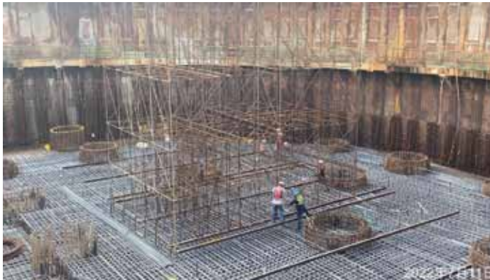
圖 2-4 主橋塔塔柱鋼筋樣架組立
