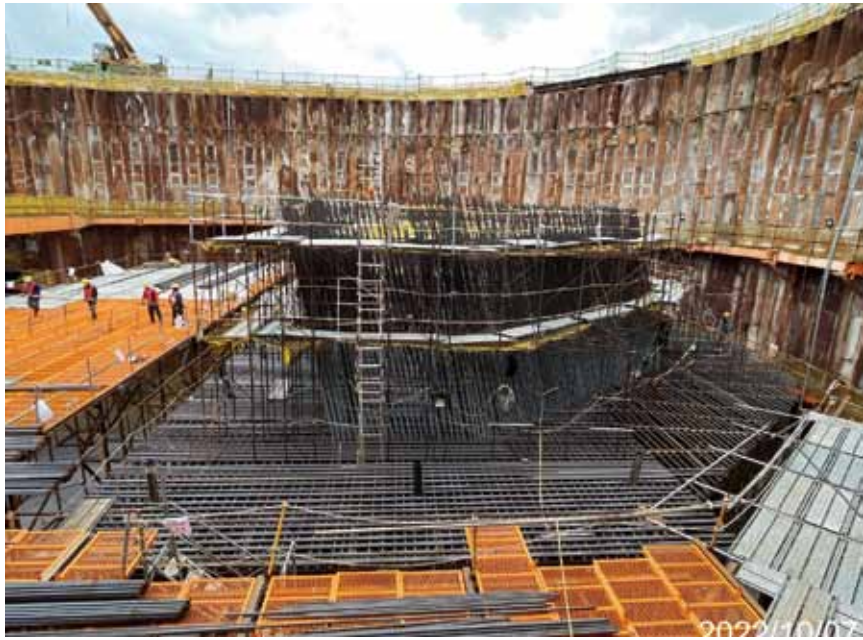
圖 4-6 橋塔外型 (主筋斜向預留)
