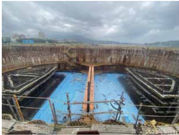
圖 3-6 保溫材鋪設
