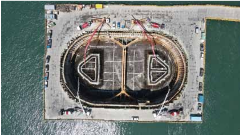
圖 3-12 樁帽混凝土澆置
