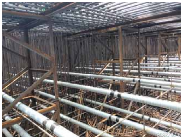
圖 2-16 樁帽預力鋼鍵套管配置
