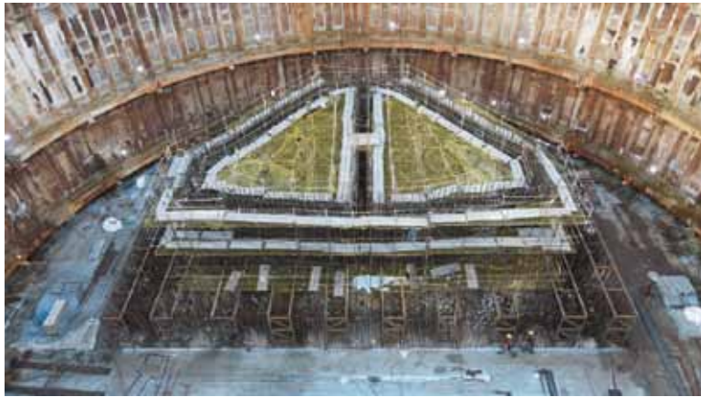
圖 4-3 基座鋼筋支撐架
