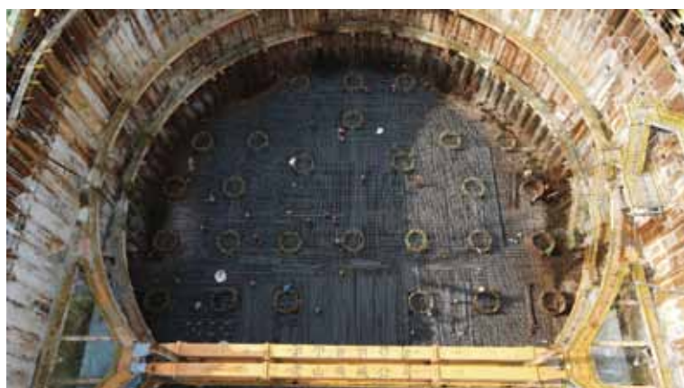
圖 2-3 樁帽下層及基座下層鋼筋
