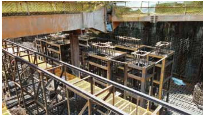
圖 2-8 塔吊預埋基座
