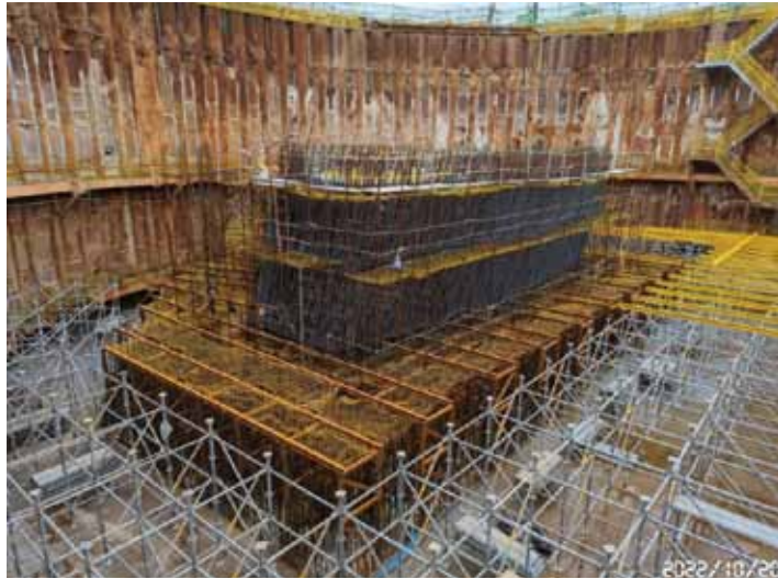
圖 4-1 基座鋼筋施工平台支撐架
