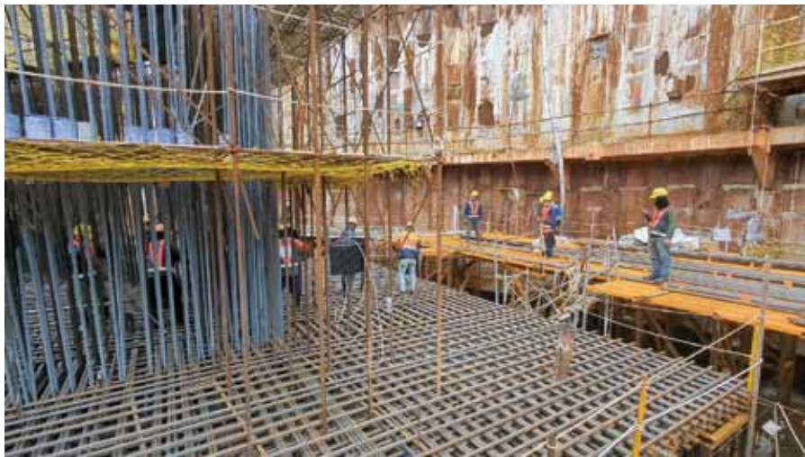
圖 4-7 基座鋼筋逐根穿越橋塔預留筋
