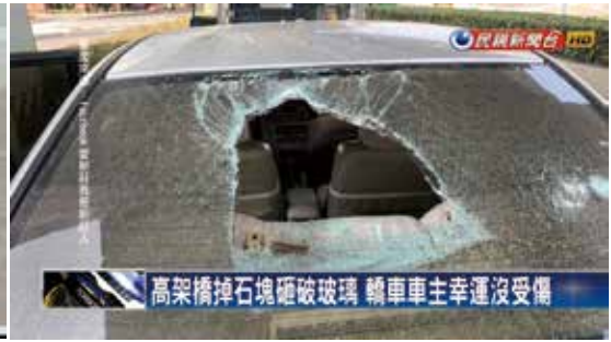
(1-2) 台 1 高架橋梁混凝土塊砸中車輛 (新聞畫面)
