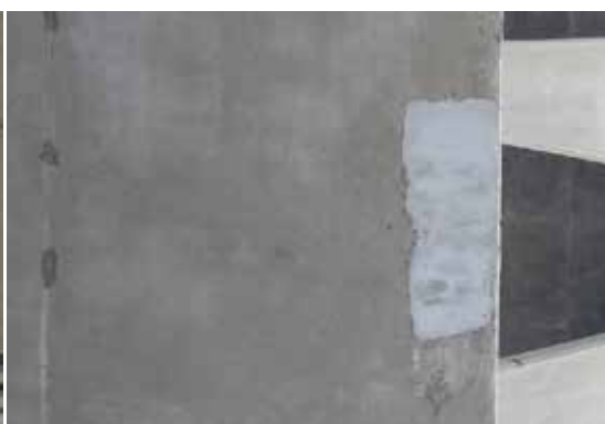
(4) 主梁混凝土劣化處 ( 修復後 )
