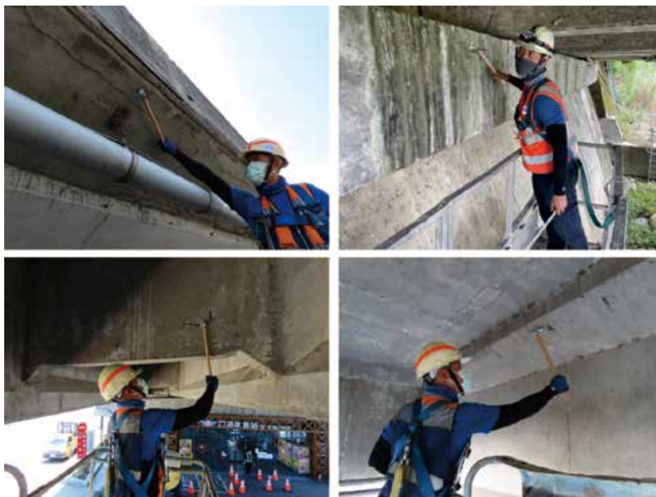
圖 3-3 手持檢驗錘敲擊檢測辨識異音及敲除鬆方工作情形
