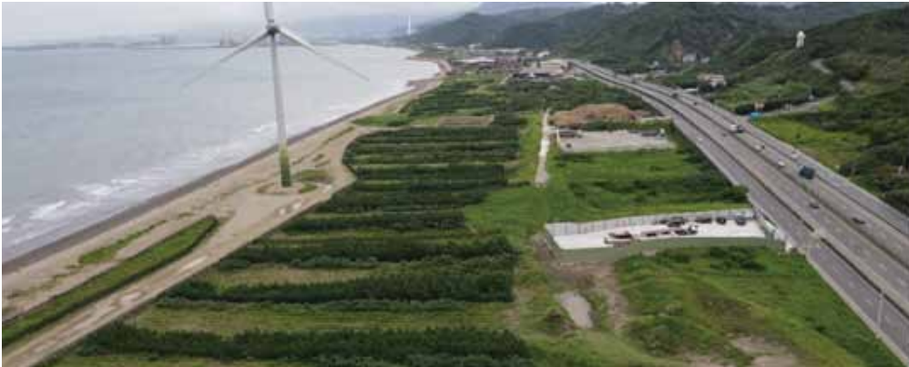
圖片來源：交通部 111 年度工程查核淡江大橋新建工程防風林新植及撫育工作，主辦機關簡報 P.A12
