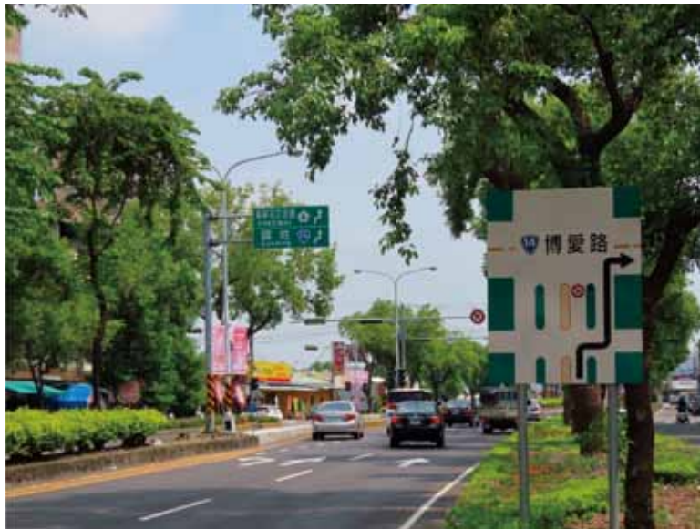
圖 8-1 台 3 線成功路快慢分隔快車道禁止右轉之行車導引資訊（「指 67」增加省道編號）
