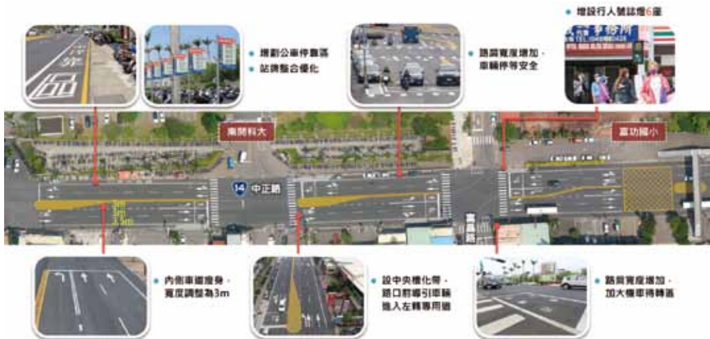
圖 6-13 台 14 線中正路南開科大路段交通工程改善成果，提升人車安全環境
