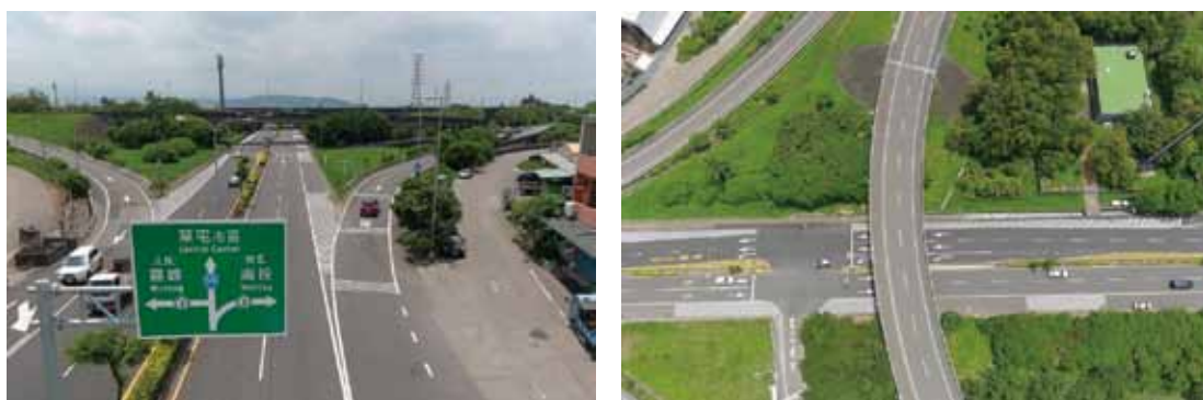
圖 3-5 台 14 線銜接國 3 草屯交流道路口預告點之圖形化標誌及偏心槽化設計
