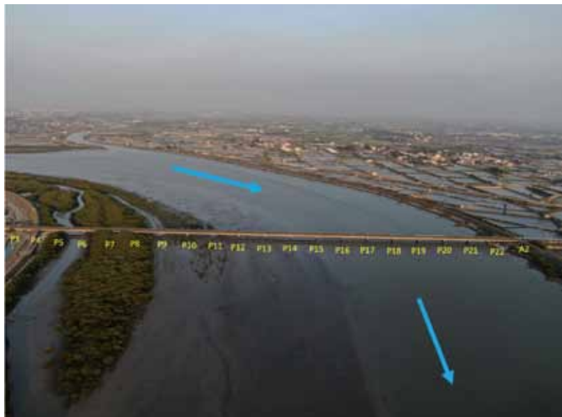
圖 1-2 東石南橋空拍照片
