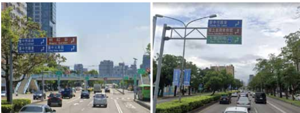
圖 8-2 臺中市臺灣大道使用已逾 13 年的指示標誌箭頭（匯出行駛慢車道）
