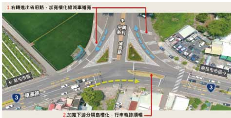
圖 3-9 台 3 線草溪路與省府路口，優化標線提供主動引導行車資訊
