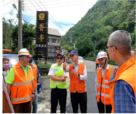
(8) 經總工指出 64.3K 道路於災後經朝 巡發現開裂即採取封閉之正確作 為，局長深表肯定
