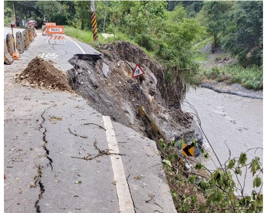
(4) 總工指示短期先以鋼軌樁構架系統來穩固邊坡
