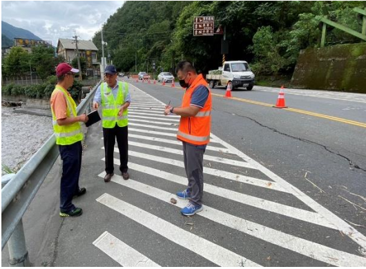
(1) 64.1K 路面縱向開裂，總工肯定朝巡發現即採取封閉單車道之正確作為，並指示以透地雷達檢視。
