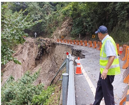
(7) 76.2K 總工檢視後指出，係水路匯集沖擊下邊坡致路基缺口
