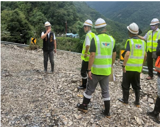
(3) 勘查 75.9K 盼能儘速恢復雙向通車及強化路基邊坡穩固
