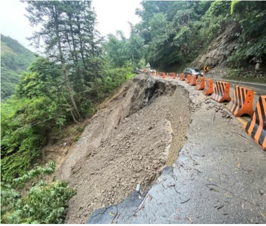
(10) 先擺放護欄以維 76.2K 路基缺口 路段之通行安全
