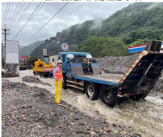
(3) 派員林段高副段長文瑞到搶通現場紀錄及回報
