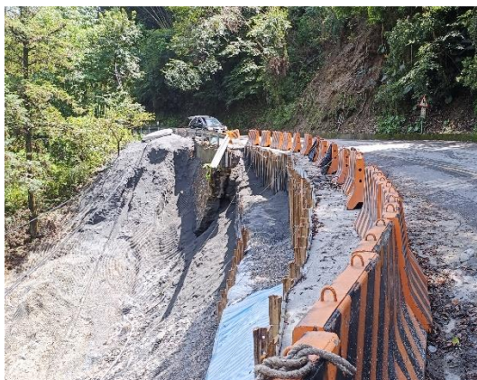
(8) 缺口下方深谷以就地崩積土回填後，採用整坡雙階鋼軌（兩階間置放太空包）擋土方式回復路基
