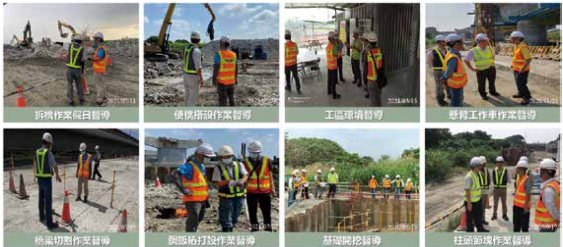
圖 4-4 監造主管巡視工地並提供職安相關要求
