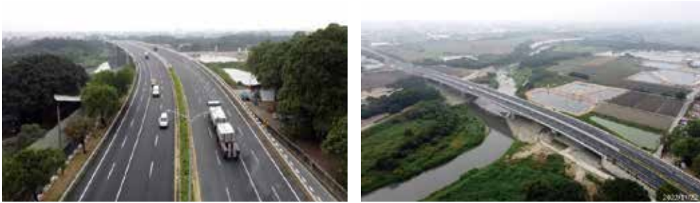
圖 7-2 工程完工現況
