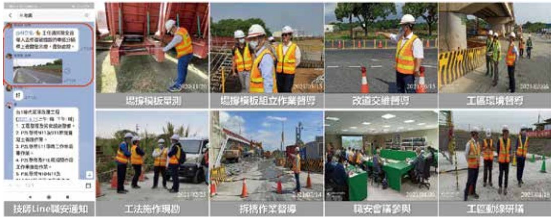
圖 4-5 監造技師巡視工地並提供職安相關要求
