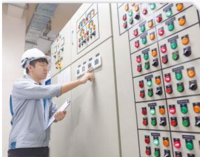
ICS 硬體易受用電量影響導致指令中斷，須確保備用電源充足，避免停電導致 ICS 關機。
