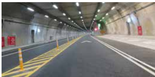
● 隧道內部區照明
