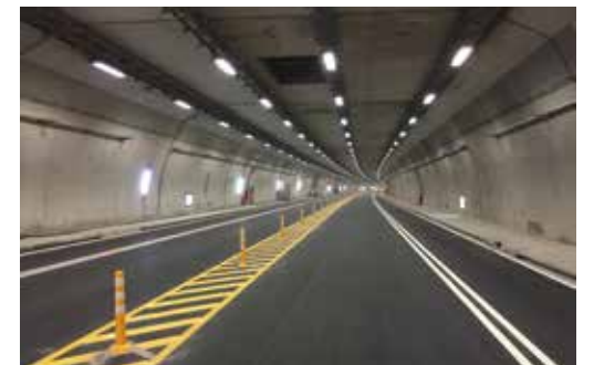
● 路面 AC 鋪設完成
