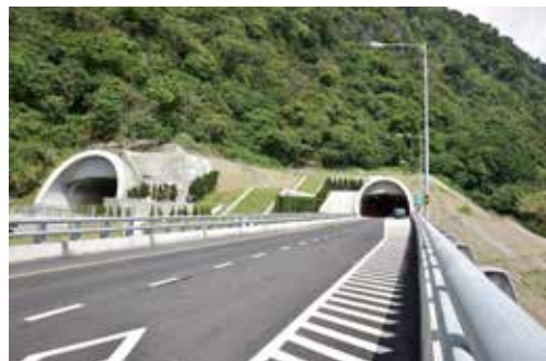
● 谷風隧道南口
