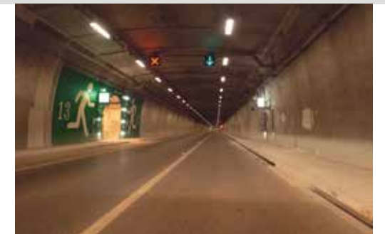
● 觀音隧道完工
