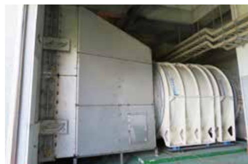
● 中仁隧道軸流式排煙風機
