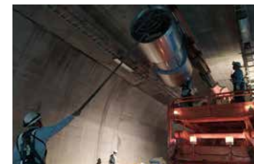
● 隧道噴流式風機安裝
