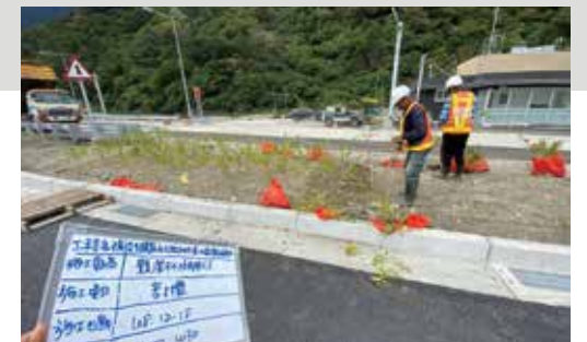
● 中仁隧道北口地磅站苦林盤 (灌木) 種植
