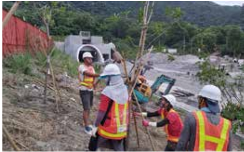
● 中仁隧道南口左側邊坡喬木種植
