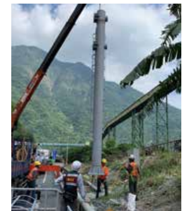
● 鋼構吊裝施工作業
