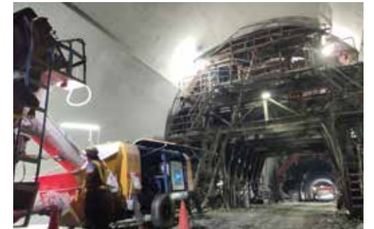
● 襯砌鋼模混凝土澆置
