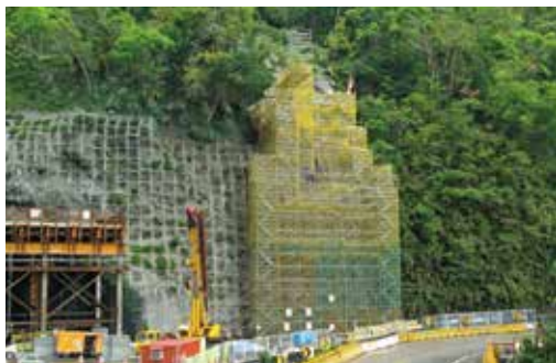
● 洞口採穩固安全之施工架搭設方式進行
