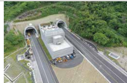
● 觀音隧道北口
