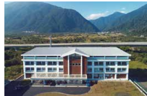
● 南澳基地 交控中心建築
