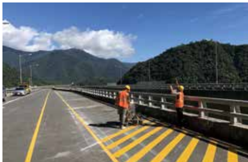
● B1標道路標線施作
