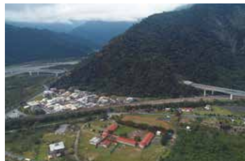
● 南澳路堤及武塔高架橋
