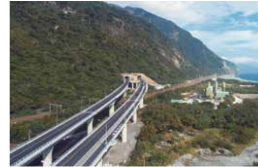
● 漢本高架橋空拍
