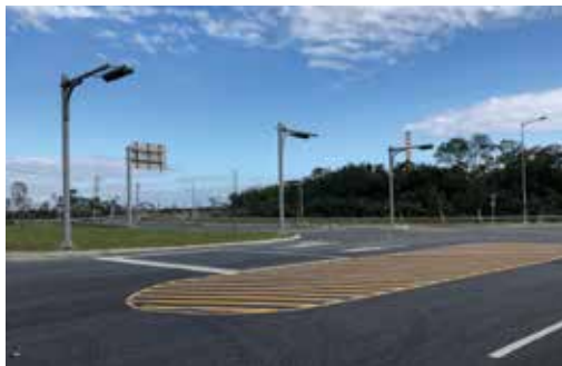
● B4標銜接克尼布東路路口標誌架及號誌燈桿施作完成
