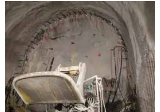
● 排氣排煙隧道開挖
