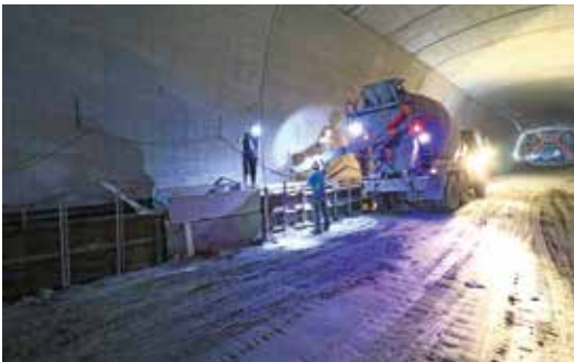
● 第 1 層混凝土澆置
