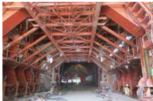
● 谷風隧道 10K 通風橫坑鋼模組裝
