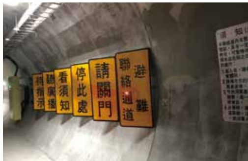
● 觀音隧道人行聯絡通道及標誌牌面安裝完成
