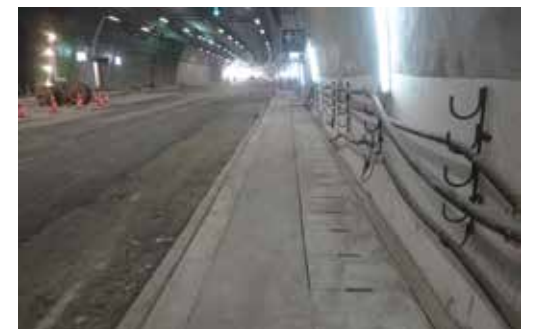
● A、B 型導線管群及消防管槽完成
