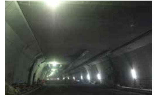
● 通風隔板完成
