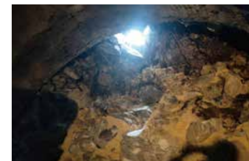
● 排氣排煙隧道開挖破鏡出洞露出曙光
