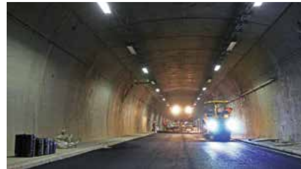
● 瀝青混凝土鋪築
