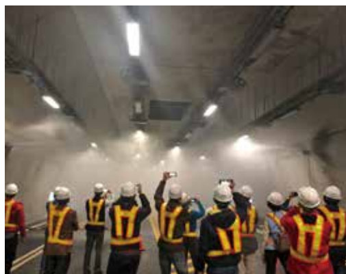
● 仁水隧道水霧系統測試情形
