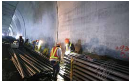
● 東側 A 型導線管群配管
