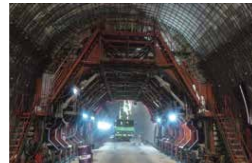
● 谷風隧道抽坍段襯砌混凝土澆置
