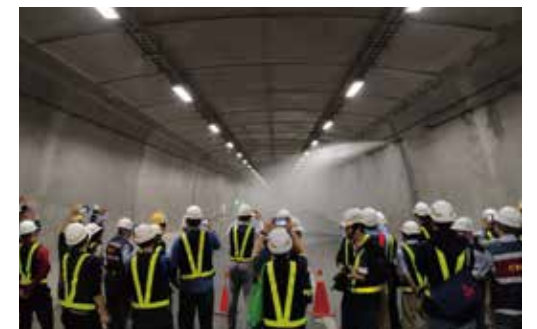
● 觀音隧道水霧系統全自動啟動噴灑
