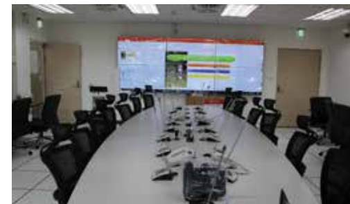
● 南澳交控中心控制室控制桌實景
