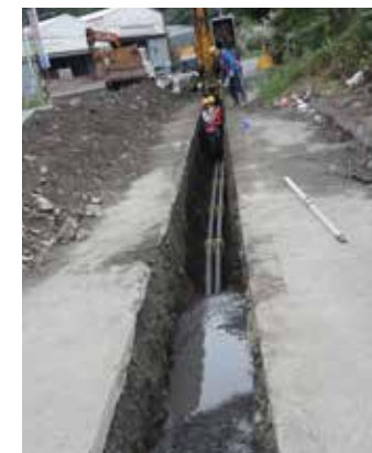
● 克尼布東路管道施工
