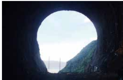
● 排氣排煙隧道開挖完成
