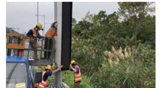
● 資訊可變標誌吊裝施工作業
