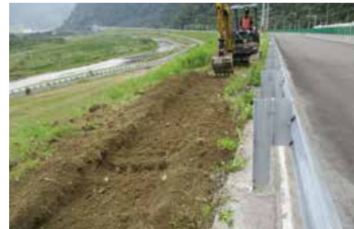
● 路堤北上車道沃土換置
