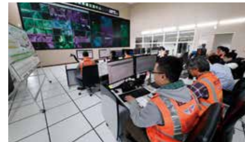
● 南澳交控中心控制室實景
